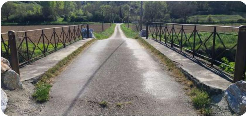
Ce calibrage est assuré par un enrochement réalisé par l’entreprise CESSÉS TP : enrochement de part et d’autre limitant le passage à 2.8m de large. Les garde-corps en fer forgé sont d’origine et donc particulièrement solides. Ils ont été redressés et remplacés par endroits par des éléments façonnés à l’identique par l’entreprise de serrurerie BAREA à Auterive.
